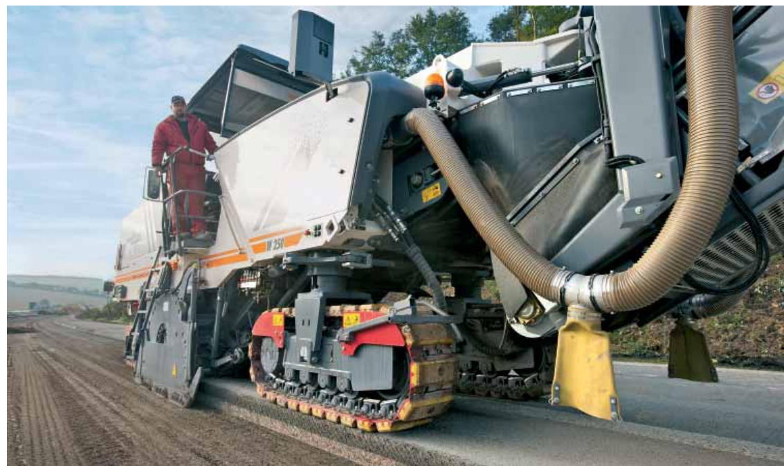
Spitzentechnik aus dem Westerwald: Eine Wirtgen-Kaltfräsmaschine im Einsatz auf einer Straßenbaustelle.
